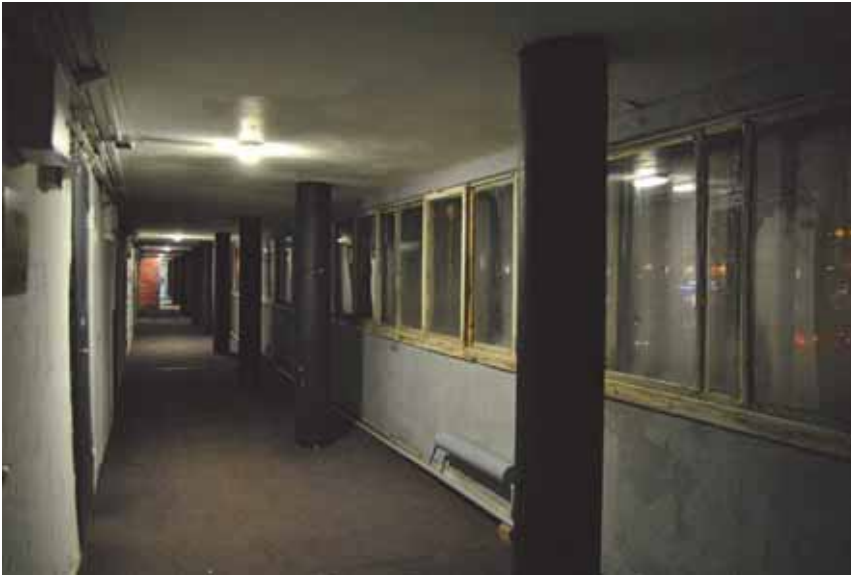
Fig. 5. Corridor in the Dom-kommuna of Narkomfin. Photo from 2018.
