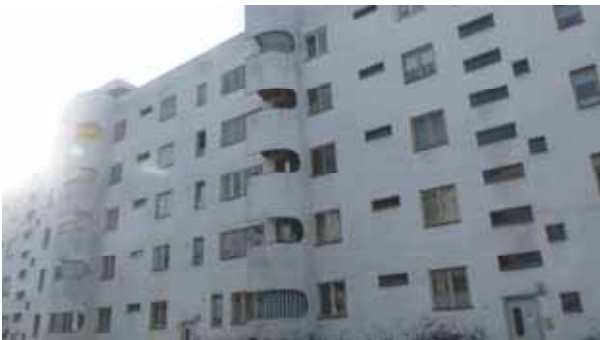
Fig. 33–35. Siemensstadt Siedlung. Arch. Otto Bartning, Fred Forbat, Walter Gropius, Hugo Häring, Paul-Rudolf Henning, Hans Scharoun, 1929–1931, 1933–34.
